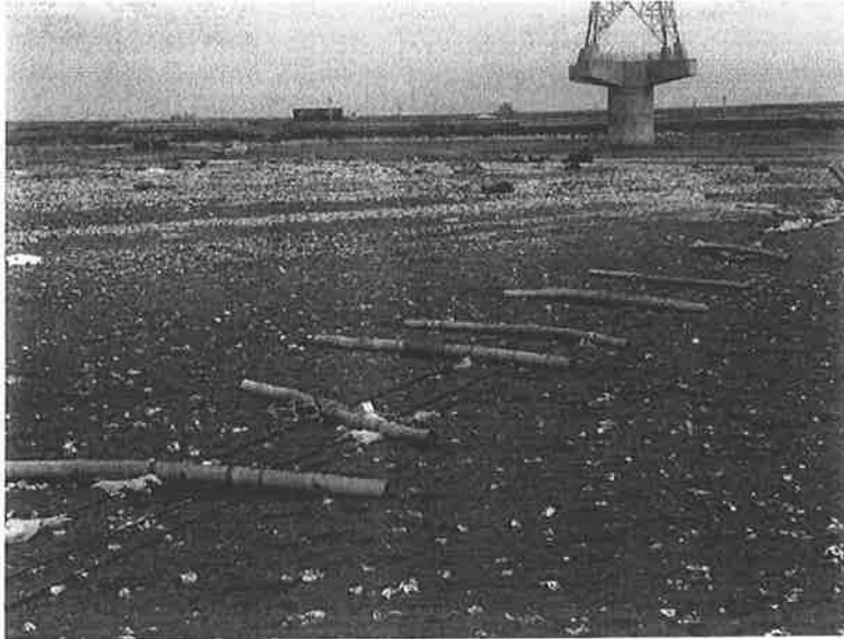
圖 33 被颱風、大浪沖垮的繁殖阻隔圍籬
