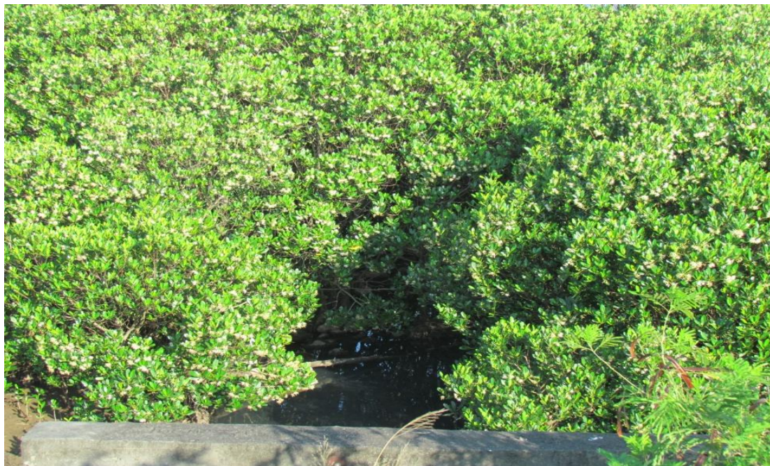
圖七、紅樹林阻礙排放口的情況
