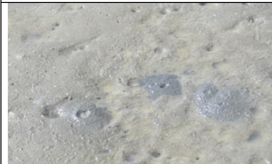
清除區西方為泥質灘地底質泥濘
